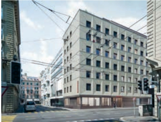
Ende August eröffnet die Raiffeisenbank Luzern in diesem Wohn- und Geschäftshaus. Bild zVg
