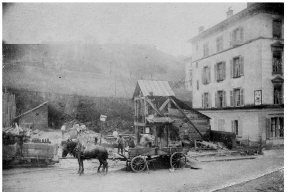
Das Gerüst des Grubenlifts, mit welchem die Lohren aus dem Tunnel auf die Strassenebene hochgehoben wurden.
