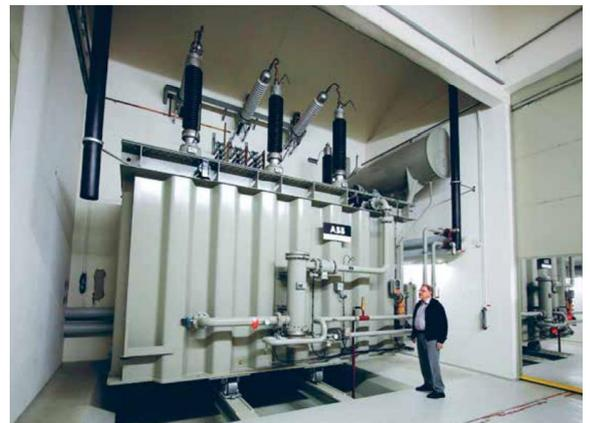
*Blick ins Unterwerk Fluhgrund: Die Anlage wurde in einem alten Steinbruch gebaut, die grossen Transformatoren sind in einer Felskaverne platziert. Mit auf dem Bild ist der Co-Autor dieses Beitrags, Benno Tschuppert.*
